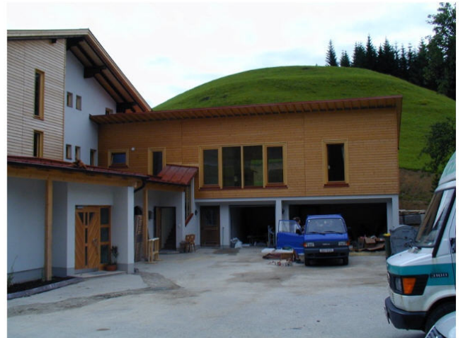
Berggasthaus in Golling Zubau und Erkervorbauten in Holzriegelbauweise
